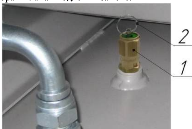
Рисунок 9 – Клапан предохранительный пружинного типа
