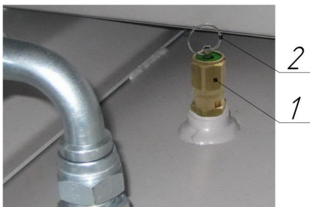
Рисунок 10 – Клапан предохранительный пружинного типа
